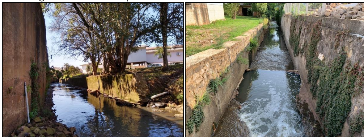
Figura 83 - Canais impermeabilizados localizado no Arroio Barracão
