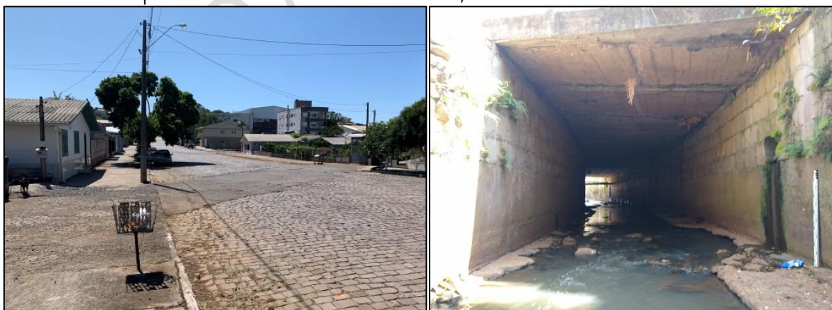
Figura 82 – Galeria fechada por onde passa o Arroio Barracão, estrutura localizada próximo ao Curtume da cidade, dentro da zona urbana
